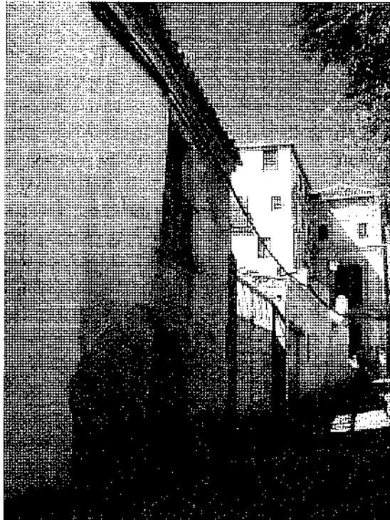
Fig. 7.- Fachada actual a la Calle de la portería de la concepción con parte del muro primitivo.
