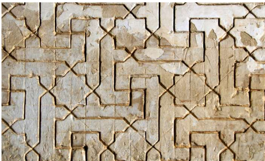
Marcas de trazado en yesería. Alhambra (corredor de acceso al Patio de los Arrayanes).
